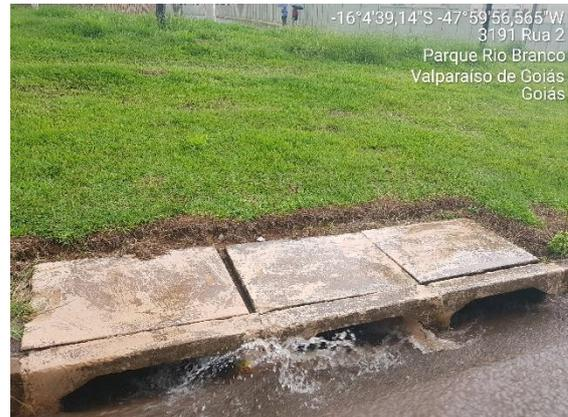
**FIGURA 16 - BOCAS DE LOBO EXISTENTES NO PARQUE RIO BRANCO NÃO COMPORTANDO A VELOCIDADE DAS ÁGUAS DA CHUVA.**
