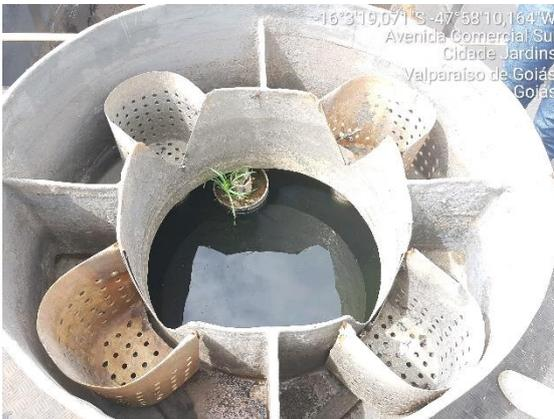
**FIGURA 13 – VISTA SUPERIOR DE UM REATOR UASB DE UMA DAS ESTAÇÕES DE TRATAMENTO DE ESGOTO.**
